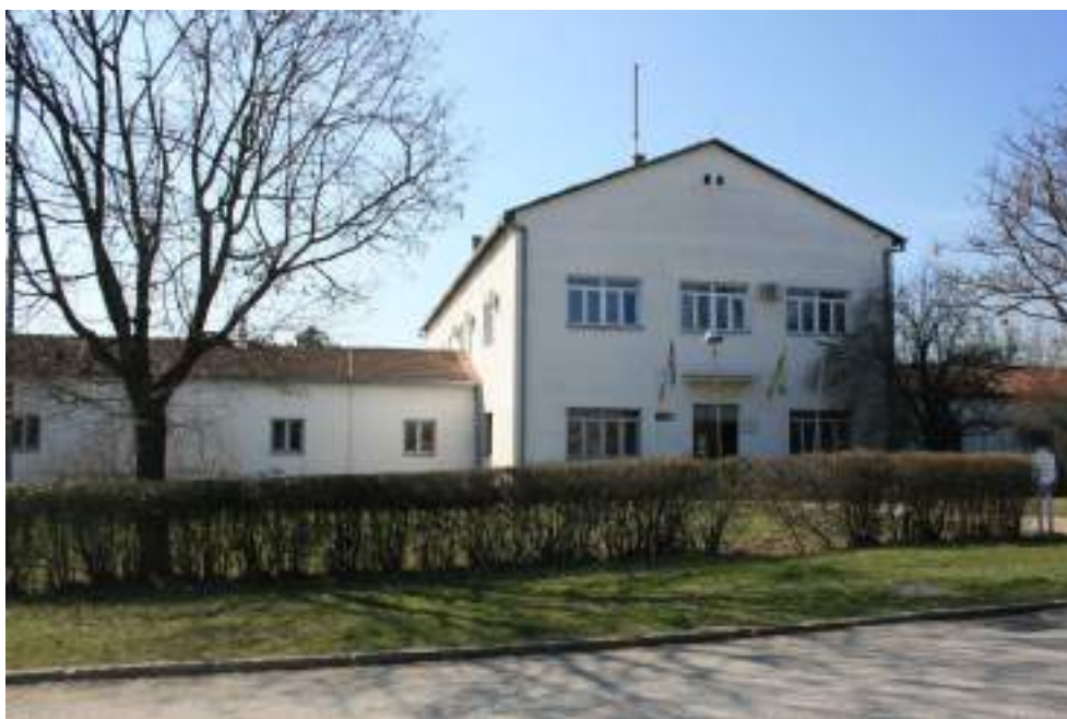
Слика бр.2– Објект Историјски Архив Шумадије Крагујевац
